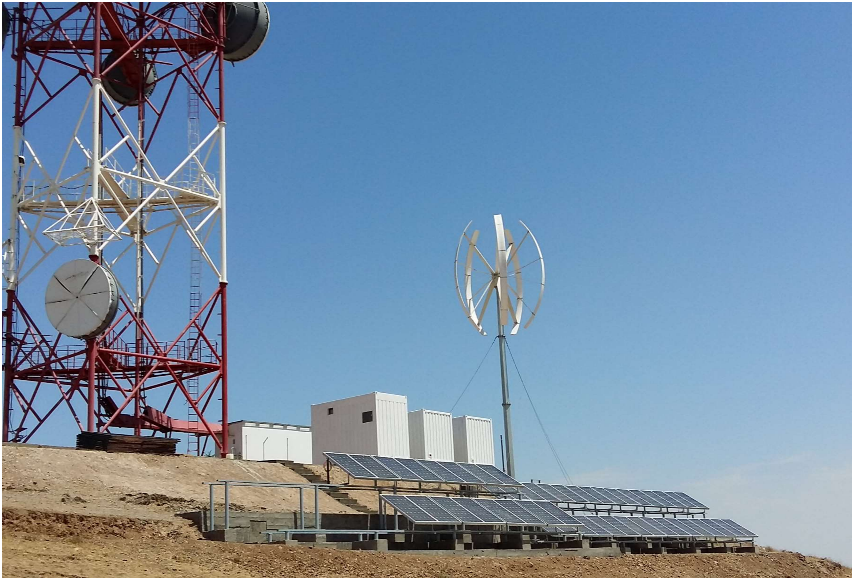
Рис. 6. Автономная солнечно-ветро-дизельная электростанция на объекте «Замбар».
