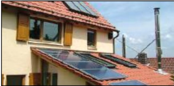
Установленные на крыши объектов поверх кровли
