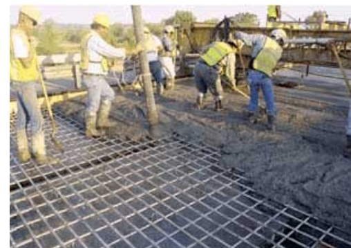
Рис.3. Строительство моста, Канада
