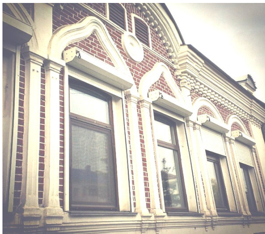
Рисунок 3. Венчающие карнизы с лентой зубчатых кирпичных кронштейнов, и Фигурные сандрики над окнами.
