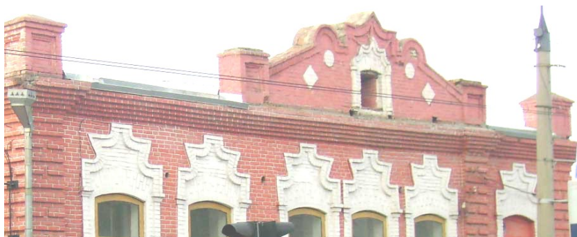
Рисунок 4. Декоративные профилированные венчающие карнизы и фигурные узорчатые сандрики над окнами.
