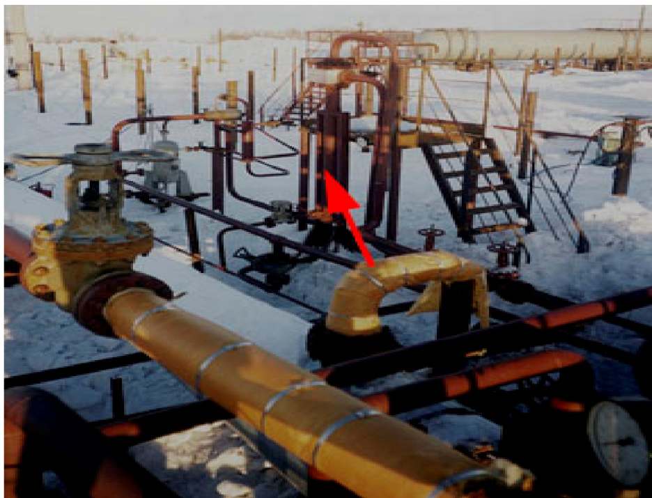
Установка очистки попутного газа перед подачей в магистральный газопровод.
